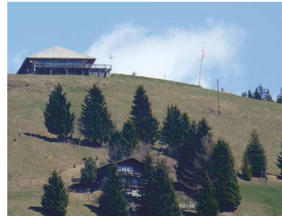
Restaurant Bühlberg mit Richtstrahlantenne
